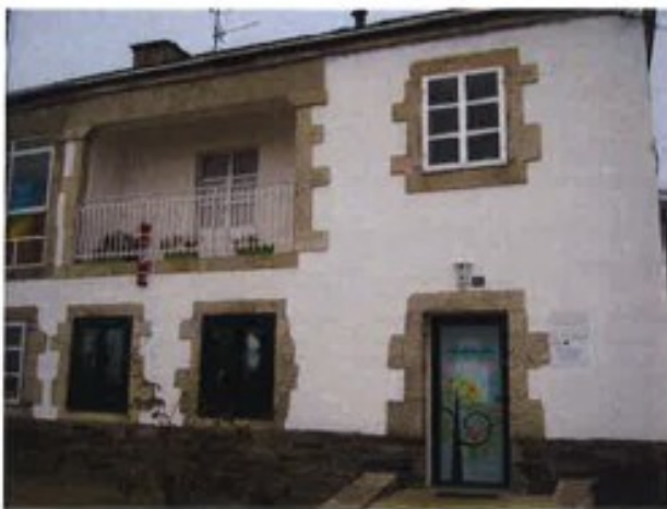
Estado do edificio antes da actuación
