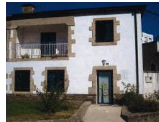
Estado do edificio despois da actuación
